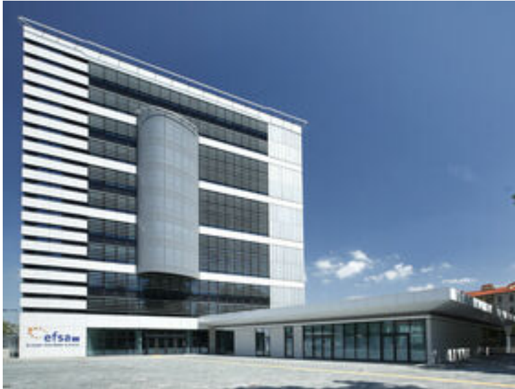
Das Hauptgebäude der EFSA in
